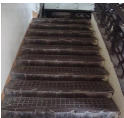
Fig: Stair case
